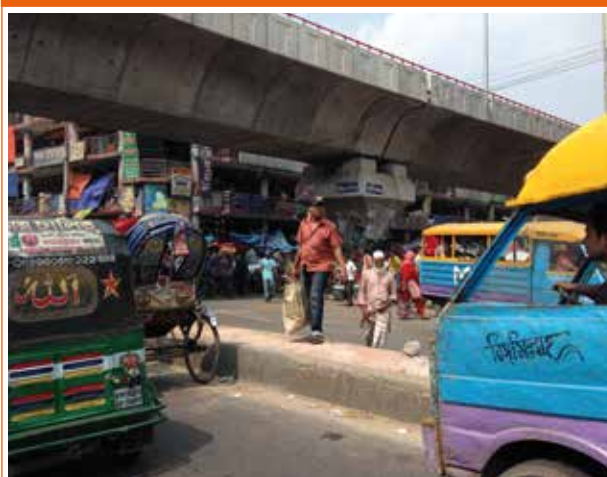
Photo 3. Route menant à l'usine
